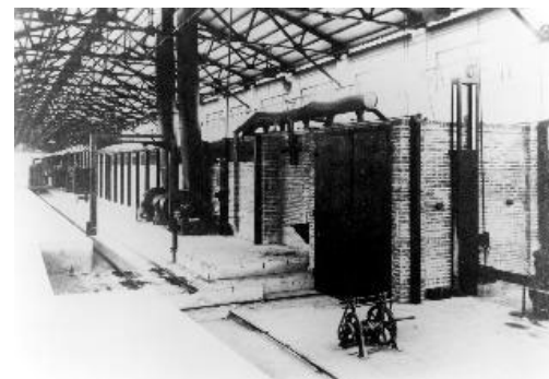
本社工場の初代トンネル窯 (1920年代)
