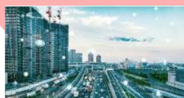
インフラモニタ・劣化診断
